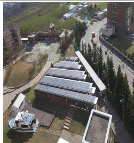
圖 1-3-2 機車停車場棚頂太陽光電系統設備
