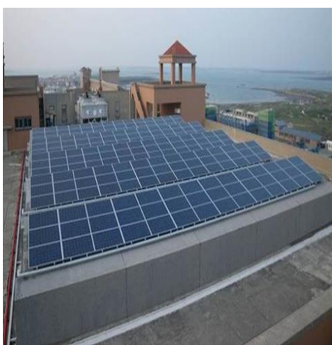
圖 1-3-2 體育館暨學生活動中心屋頂太陽光電系統設備
