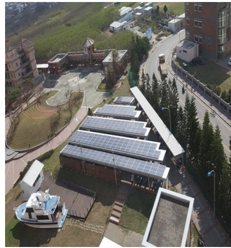
圖 1-3-3 機車停車場棚頂太陽光電系統設備
