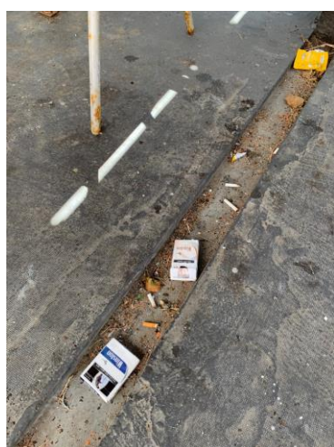
實驗大樓五樓太陽能板處
