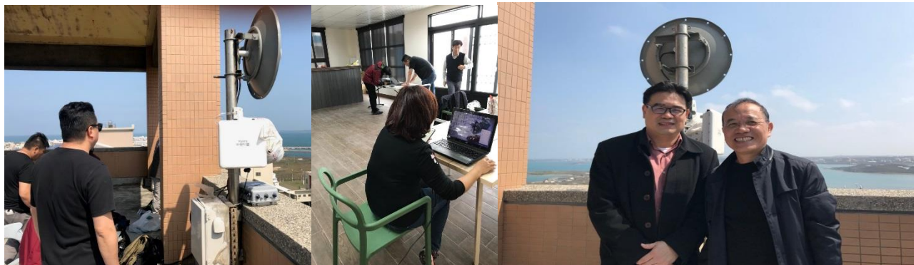
圖:高速網路系統的建置工作情形
