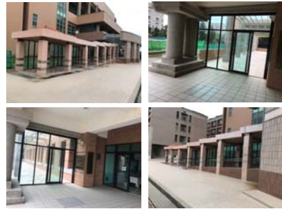
風雨走廊設置
