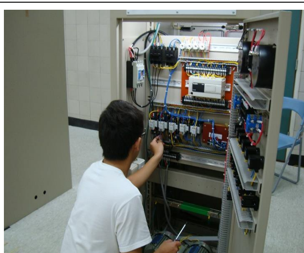
工業配線乙級實習教室
