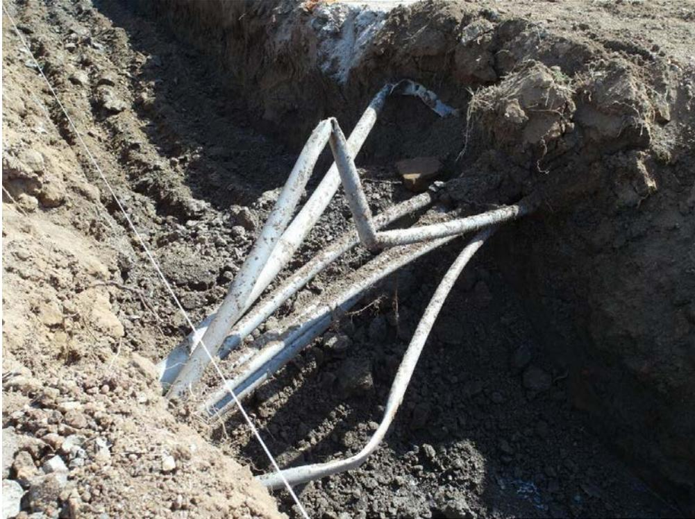
如上圖所示，昨天 9/15 下午 16:49 時，本期系統數據傳輸系統發生問題，至現場勘查時發現管路被挖到變形。管路中所包含通訊及電力，今天勘查目前是發現電力中斷導致設備異常。
