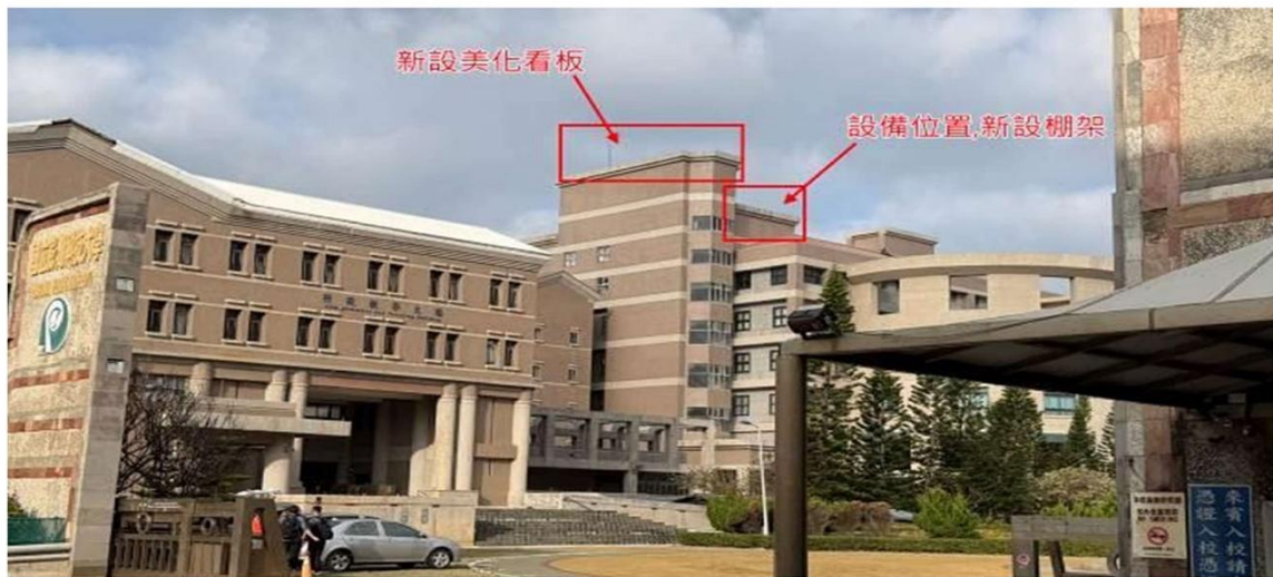
圖資大樓設置 FRP 天線美化看板、棚架之位置及示意照片
