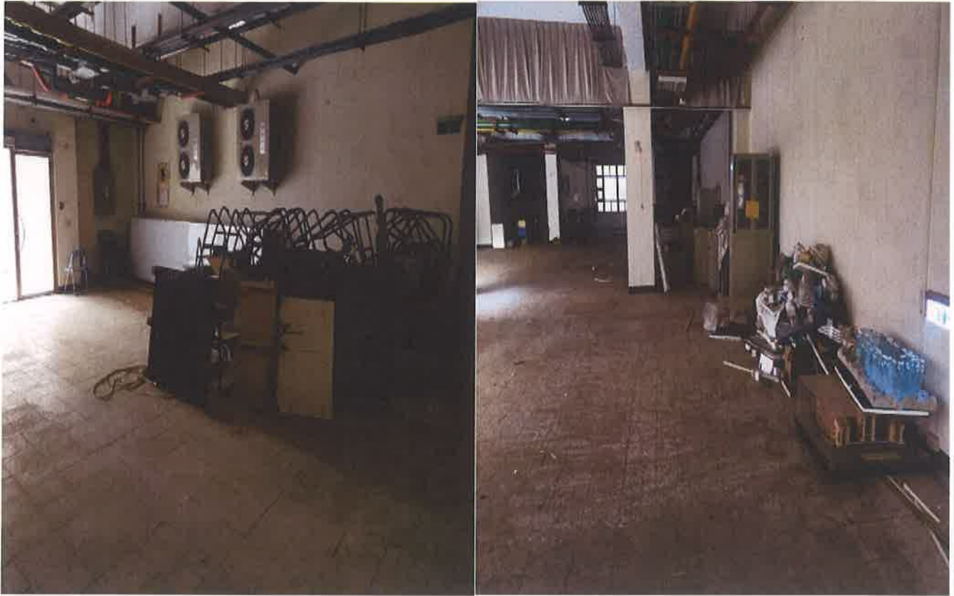
實驗大樓地下室(使用單位:餐旅系及觀休系)
