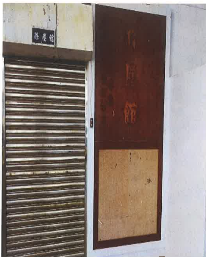
行政大樓前棟四樓(使用單位:觀休系)
