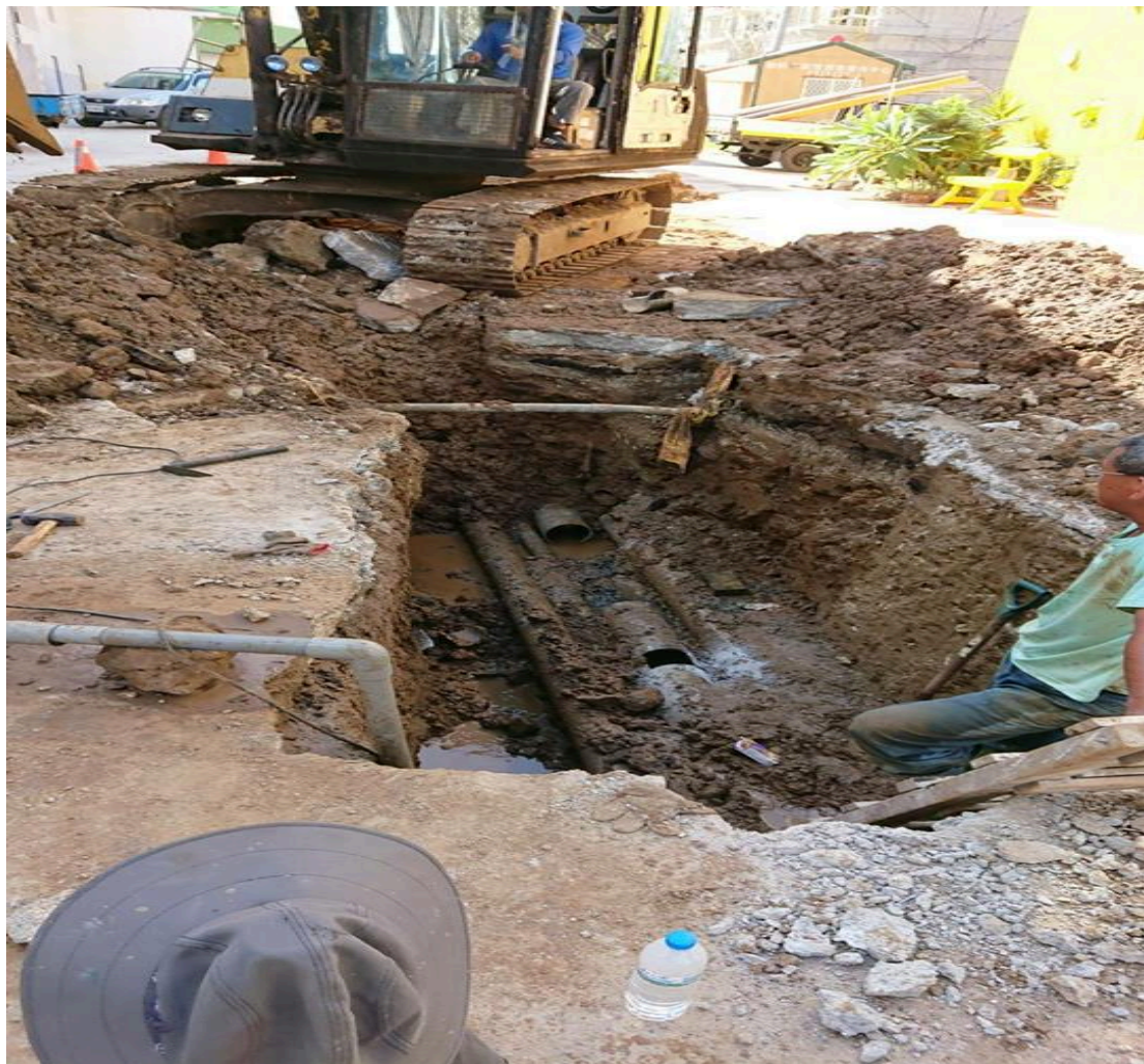
圖二：地下管線破損維修
