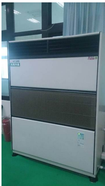
圖五 提升運動環境品質-裝置 8RT 冷氣
