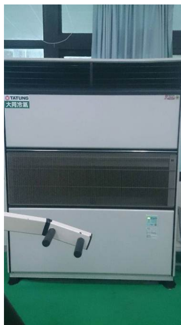
圖五 提升運動環境品質-裝置 8RT 冷氣
