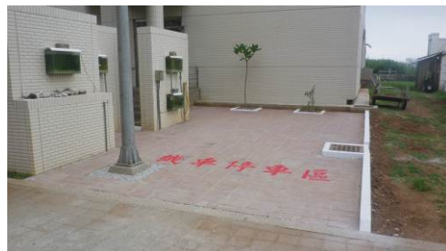
海科大樓北棟東側增設機車停放區(約 15 部)
