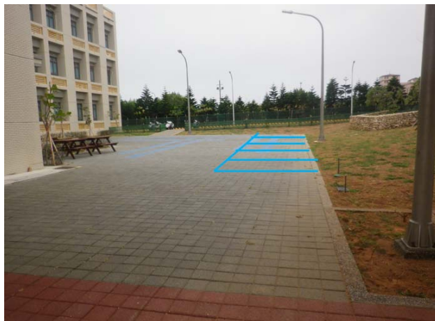
海科大樓南棟北側
